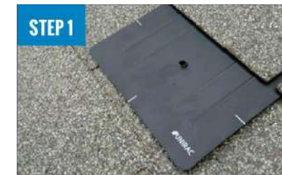
INSTALL FLASHKIT PRO FLASHING
